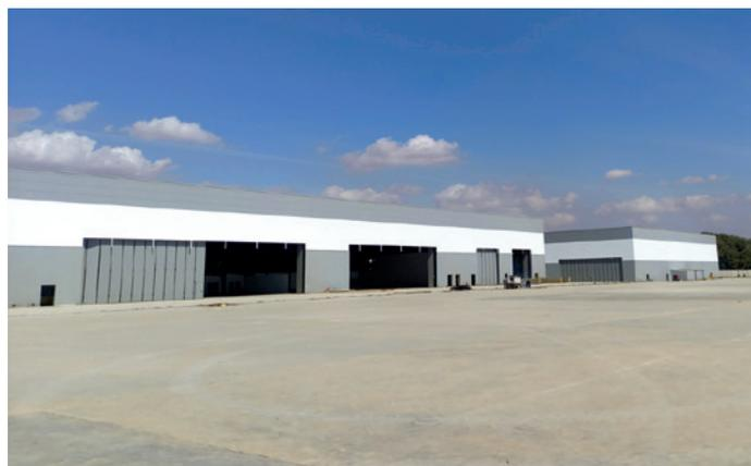
L'Autre défi Majeure que les équipes de projet ont relevé, consiste en la réalisation de Dallage extérieur qui s'étale sur une surface de 38 800.00 M<sup>2</sup> d'une épaisseur de 30cm avec une précision quasi parfaite pour permettre le drainage des eaux pluviales.
