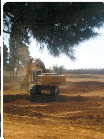
de camions travaillant à un rythme accéléré (plus de 40 000 m<sup>3</sup> de déblais sont évacués en 10 jours) ; Puis, une présence d'eau a été effectivement rencontrée et a nécessité des travaux de drainage et de déviation des sources, sur toute la périphérie du projet et sur un linéaire de plus de 240 m.
